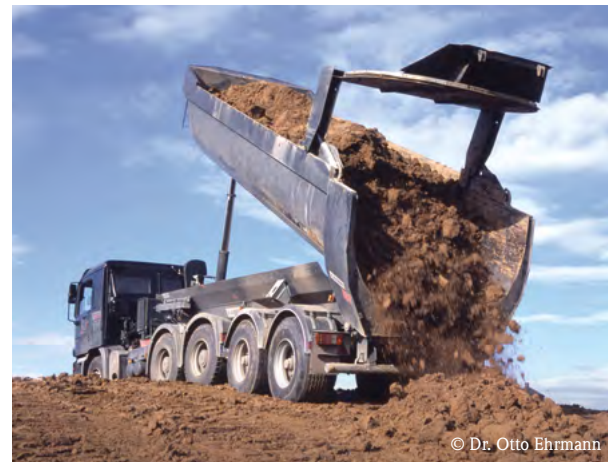
Abkippen von Bodenmaterial
